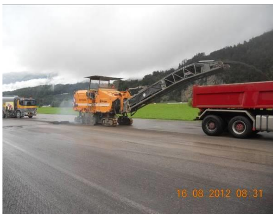
Foto 6.3: Korrekturfräsung auf -4 cm
