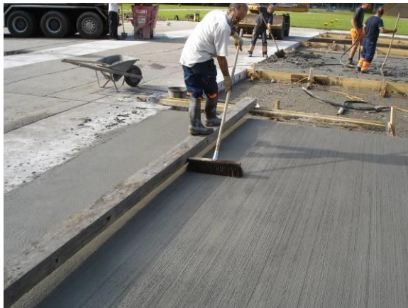
Foto 6.15: Oberflächenstrukturierung
