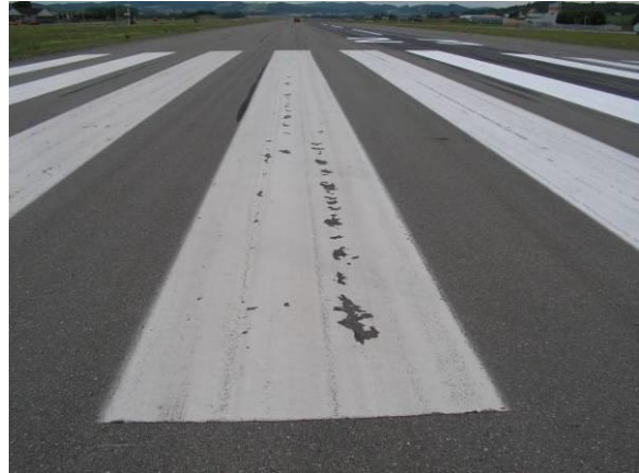
Foto 6.26: Beispiel von zu dick aufgetragener Markierung (Schuppen)
