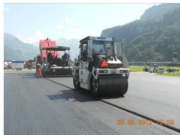
Foto 6.4: Deckbelagseinbau 4 cm
