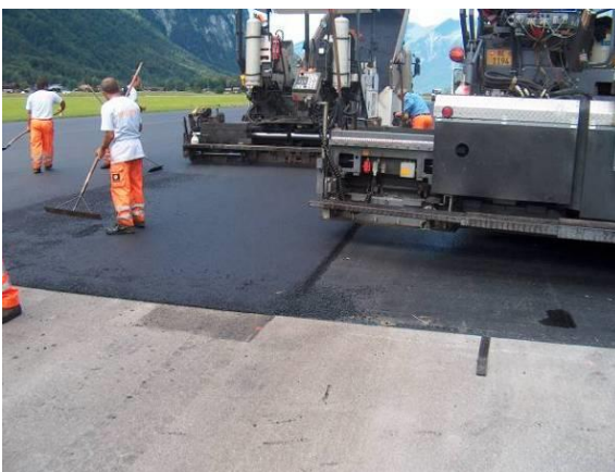
Foto 6.7: Einbau Deckschicht
