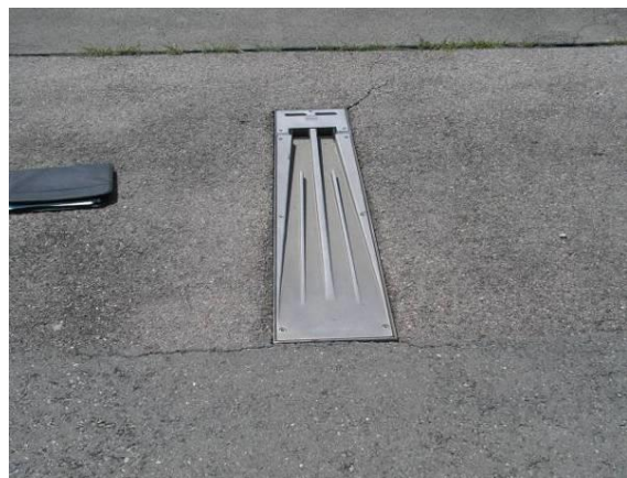
Foto 6.24: Typ Einbaufeuer lang (z.B. IL 20)
