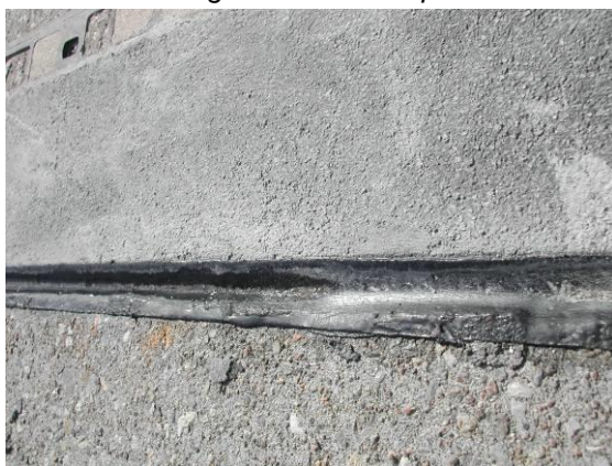
Foto 6.12: Sanierung Fuge
