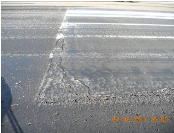
Foto 6.25: Beispiel von Gummiabrieb und dick aufgetragener Markierung (Schuppen)
