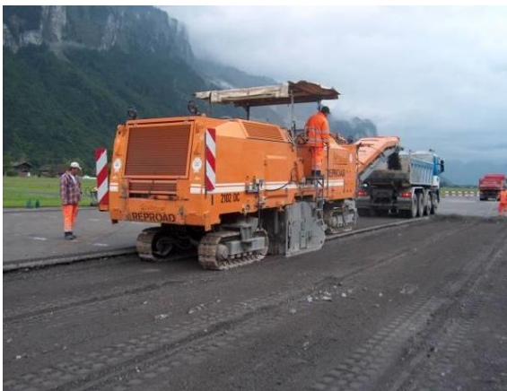
Foto 6.5: Abfräsen Deck- und Tragschicht
