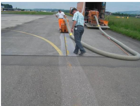
Foto 6.29: Kugelstrahlen vorne auf Belag, hinten auf Beton
