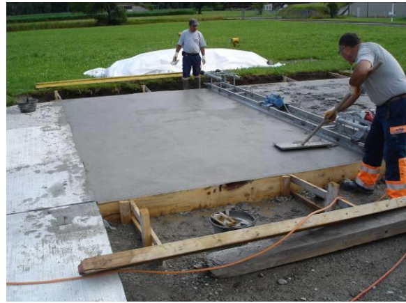
Foto 6.14: Einbau Beton
