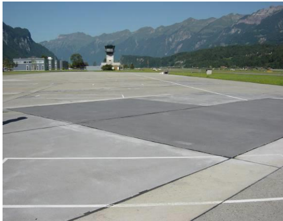
Foto 6.10: Fertig sanierte Betonplatten
