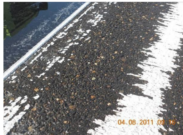
Foto 6.32: Beispiel beschädigter Belag in folge zu hohem Strahldruck
