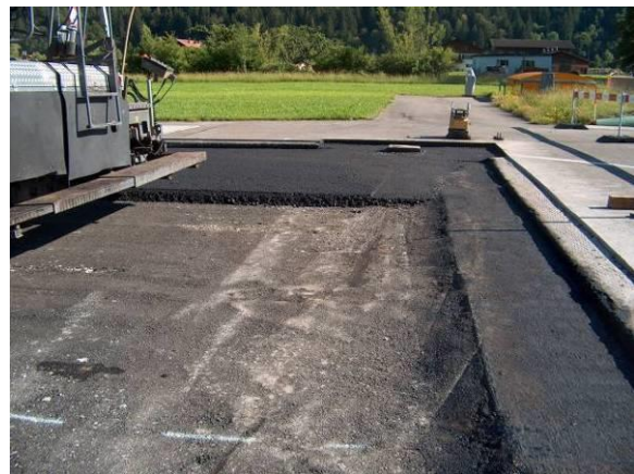
Foto 6.6: Einbau Heissmischfundationsschicht
