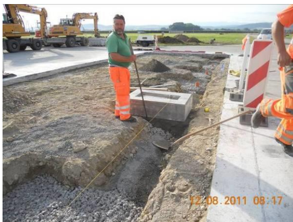
Foto 6.20: Sickerbetonbett
