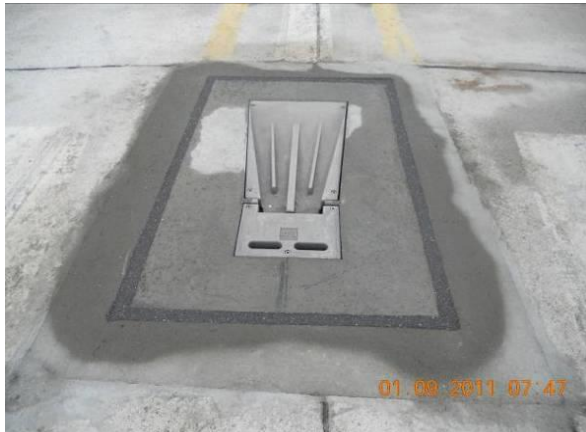
Foto 6.21: Typ Einbaufeuer kurz (z.B. IL 20)
