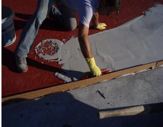
Foto 6.8: Applizierung Gussmasse
