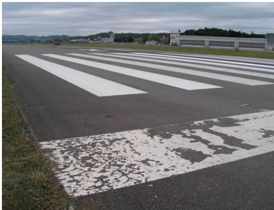
Foto 6.27: Beispiel von zu dick aufgetragener Markierung (Schuppen)
