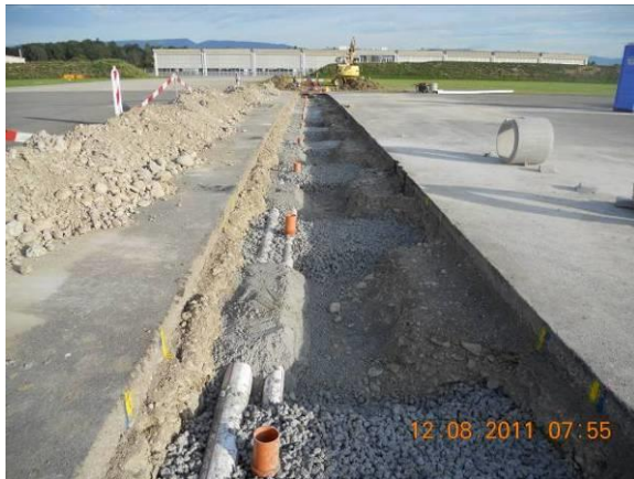
Foto 6.19: KSR-Anschluss zur Aussparung im Betonsockel
