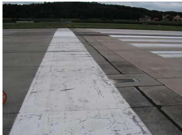
Foto 6.28: Beispiel von zu dick aufgetragener Markierung mit neuerer Übermalung
