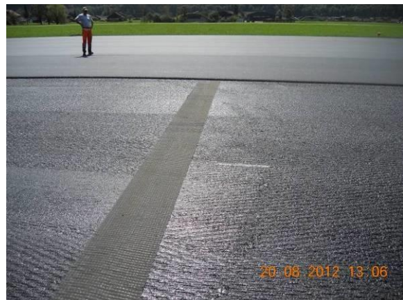
Foto 6.2: Haftvermittler, Belagsarmierung
