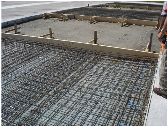
Foto 6.13: Querkraftdorne, Armierung
