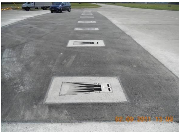
Foto 6.23: Typ Einbaufeuer kurz (z.B. IL 20)
