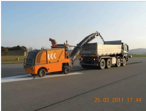
Foto 6.30: Fräsung Markierung
