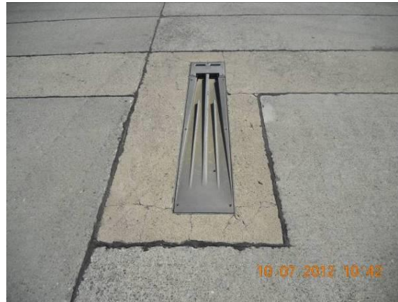
Foto 6.22: Typ Einbaufeuer lang (z.B. IL 20)
